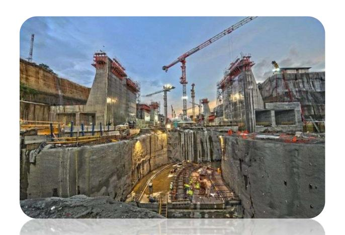
Este proyecto se basa en la construcción de nuevas esclusas, una en lado Atlántico y otra en el lado Pacífico del Canal, para permitir el paso de buques tamaño Post-Panamax, los cuales, dado que superan el tamaño Panamax, actualmente no pueden navegar por la vía interoceánica. El costo aproximado de esta operación según la Autoridad de Canal de Panamá (ACP) será de 5.250 millones de dólares.
