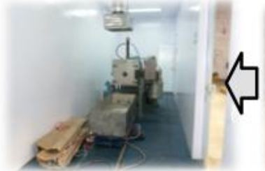
Ups, sistema de extracción – no resultó...
