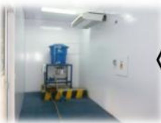
Sistema de recirculación de agua
