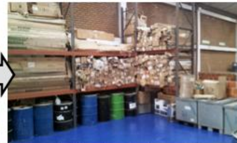
Adecuación instalaciones de almacenamiento
