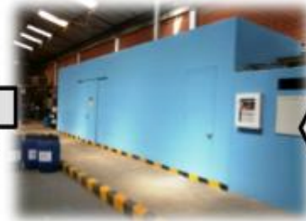
Construcción cuarto de aislamiento
