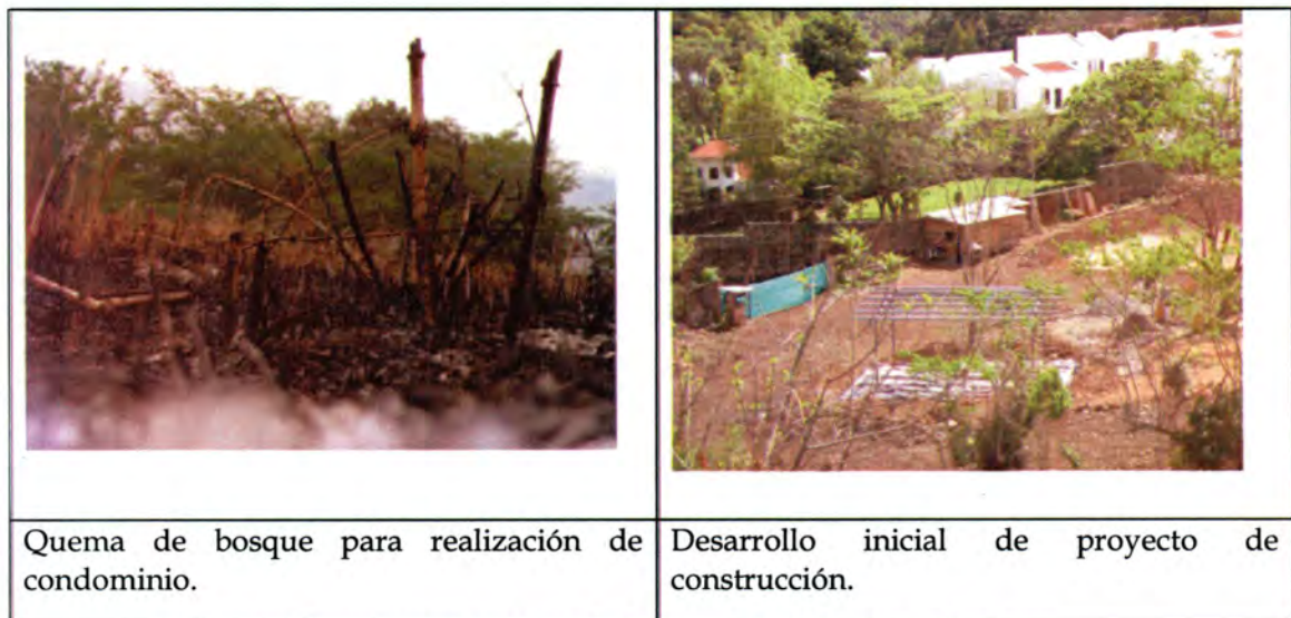
Figura 15 Fotografía en la zona de la Curva del Boffe. Punto Crítico A.
