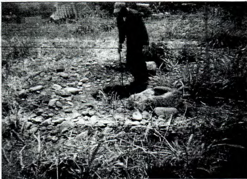
Apique efectuado para observar en forma directa la conformación del subsuelo. Se aprecian en él gravas, cantos y guijarros.
