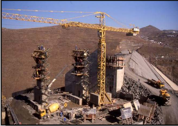
Grúas de Construcción
