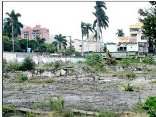
Símbolo social. Así quedó el lote del club San Fernando, de la Calle 5 con Carrera 36, luego de la venta y demolición de este emblemático centro social de Cali. Áymer Álvarez / El País
